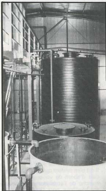
Silo de stockage de la chaux utilisée en neutralisation.
