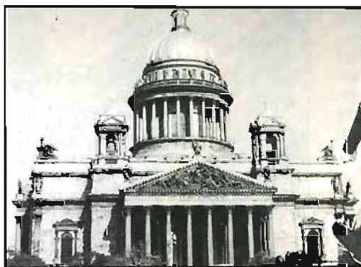
Léninegrad : Cathédrale St-Isaac (1918-1958). Superficie 4000 m 2 . Architecte Auguste Montferran.
