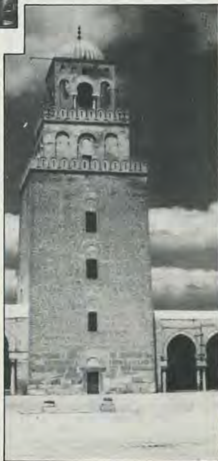
Minaret de la mosquée de Kairouan.
